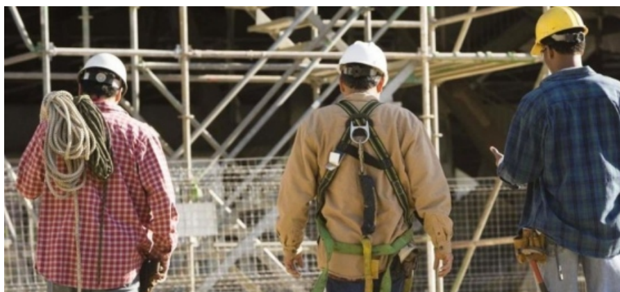
Operai al lavoro
